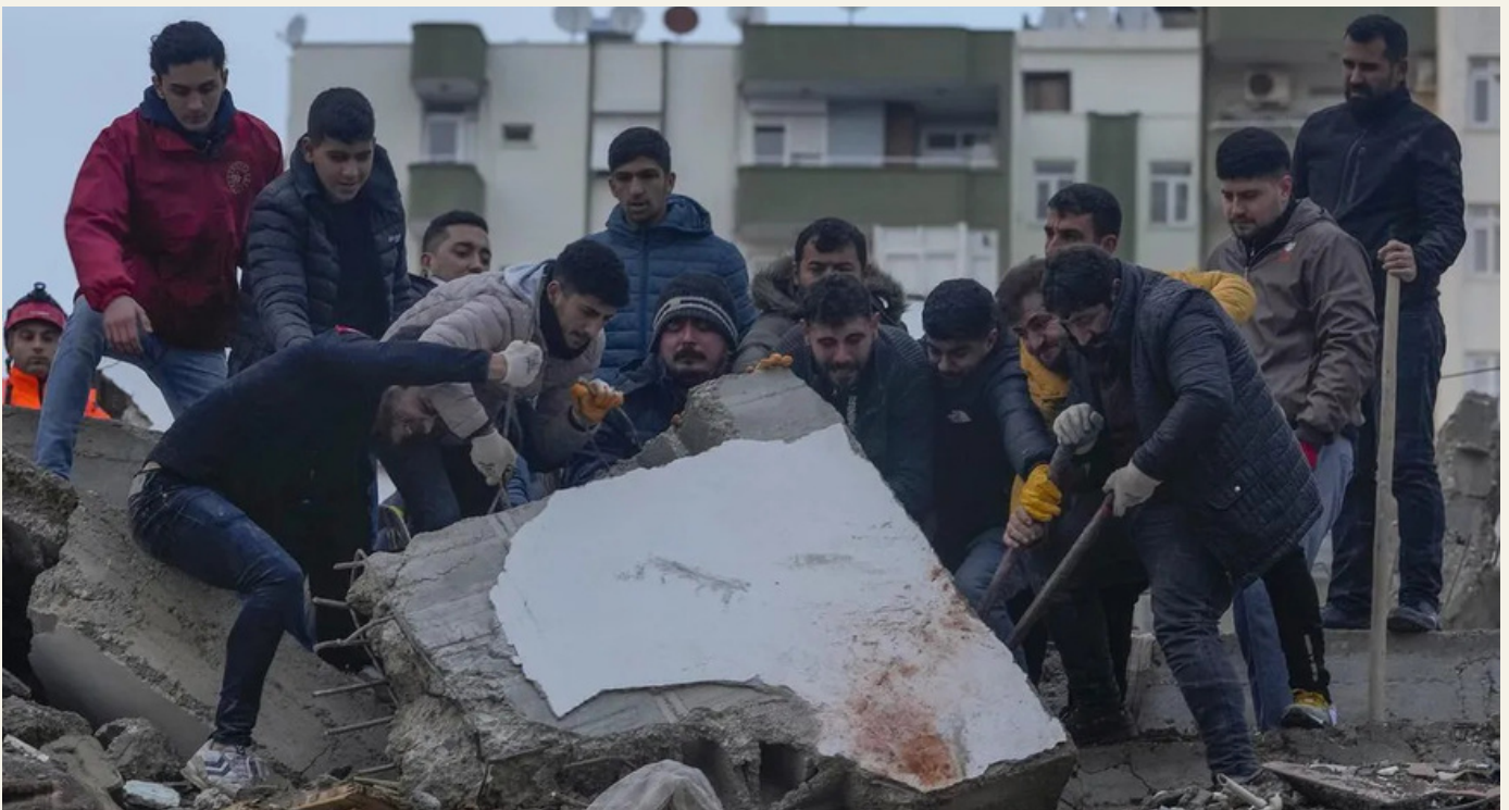
Homens procuram pessoas entre os escombros de um prédio destruído em Adana, Turquia (AP Photo/Khalil Hamra)
